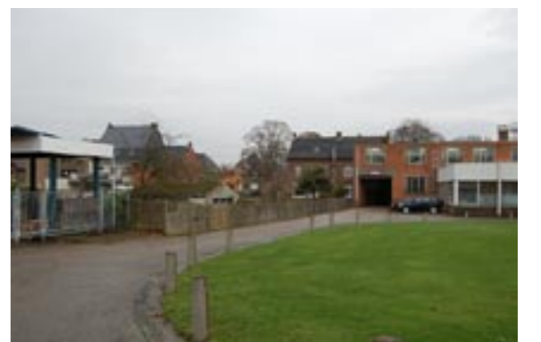
16. Bijbouw werkplaats mechanica (1977)
