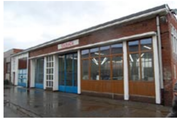
9. Werkplaats 'garage', jaren 1960. Originele gevelelementen in beton en stalen schrijnwerk.
