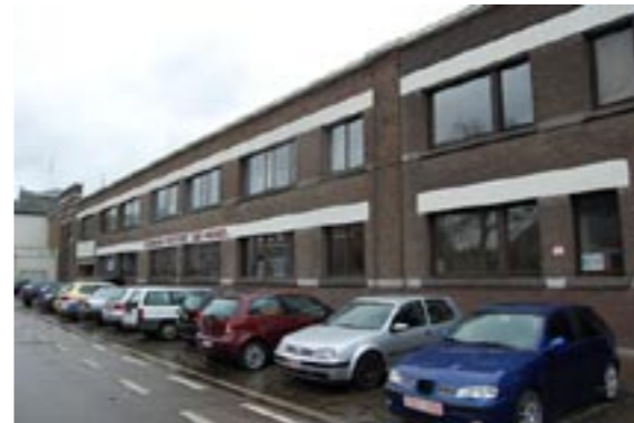
14-15. Voormalige gebouwen 'Centra'. Meest karaktervolle gebouwen van de TISM-site, alleszins de straatgevel en de constructieve opbouw. Het hoofdgebouw (14) is een betonskelet met groot daklicht. De voorgevel heeft een sterk horizontaliserend effect, de achtergevel is veel minder interessant. De 'opslagplaats' (15) is een grote kolomvrije ruimte met stalen dakspanten. De achtergevel ( of achterbouw) is gesloopt en met industriële materialen dichtgemaakt. De voorgevel van dit gedeelte wijkt af van het horizontaliserende principe en staat bijna op zichzelf: het is een combinatie van horizontale betonnen gevelelementen en verticale raamnissen met stalen schrijnwerk (in erg slechte staat).
