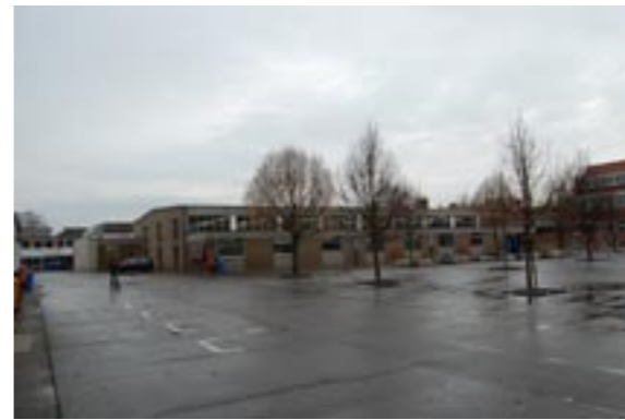
11-12-13. Oude en nieuwe schrijnwerkerij (1971 en 1998). Industriebouw: staalstructuur met gevelbekleding in prefab-betonpanelen.
