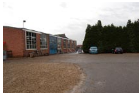
10. Werkplaats 'lasafdeling' uit dezelfde periode. Stalen vakwerk onder hellend dak.
