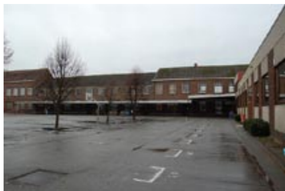
5-6-7-8-9-10. Aaneengeschakeld gebouwencomplex van verschillende periodes (1921-1960-1976). Deze zijn elk van die aard dat ze zich typologisch gezien wel tot herbestemming zouden kunnen lenen (rationele structuur, compartimentering,...), maar dat dit waarschijnlijk niet zal opwegen tegen de financiële consequenties die een renovatie met herbestemming tot woonfunctie met zich zal meebrengen.
