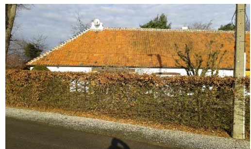
Gerestaureerde hoeve als woning
